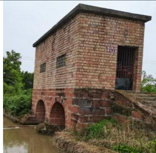
塘叫沟泄洪闸现状(闸室变形、闸房漏水、闸门锈蚀等问题)
