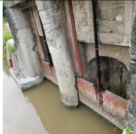
塘叫沟泄洪闸现状(闸室变形、闸房漏水、闸门锈蚀等问题)
