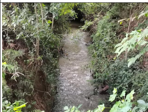
主干渠典型现状（未衬砌）
