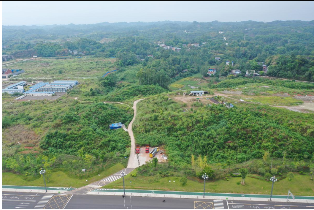
施工场地现状情况
