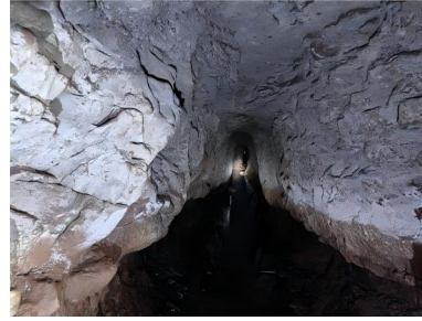
九龙干渠汉坡林隧洞现状
