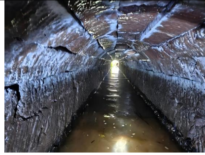
右干渠罗坳儿暗涵现状
