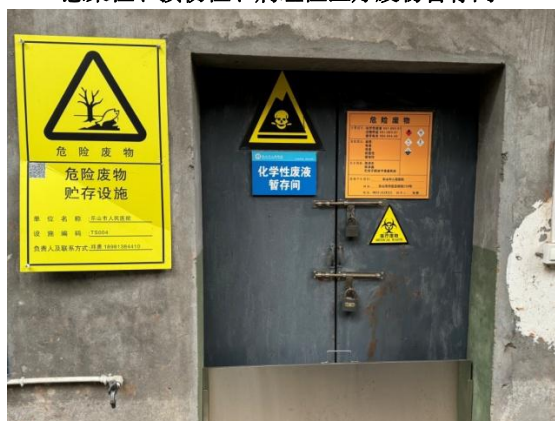
化学性废液暂存间
