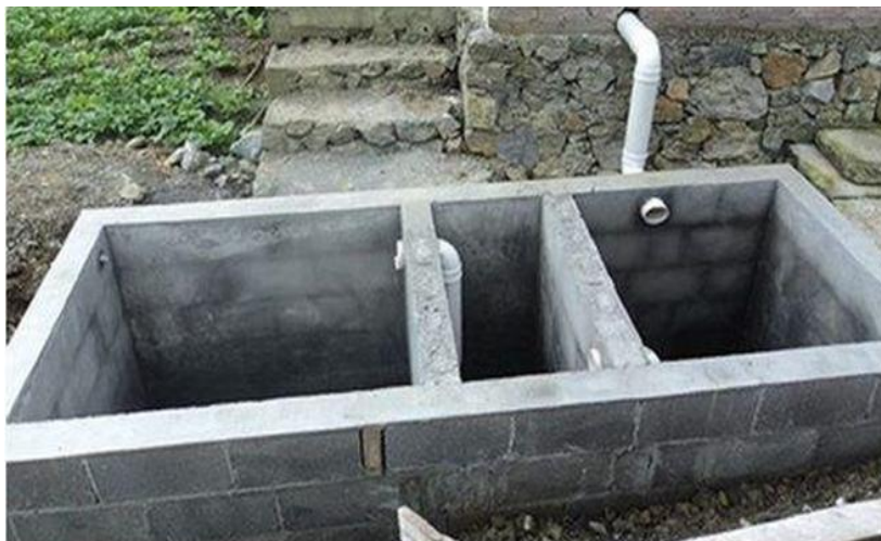
图 2-3 砖砌三格化粪池示意图
