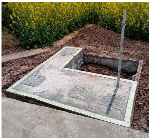
图 2-4 三格化粪池+隔油池+人工湿地模式示意图
