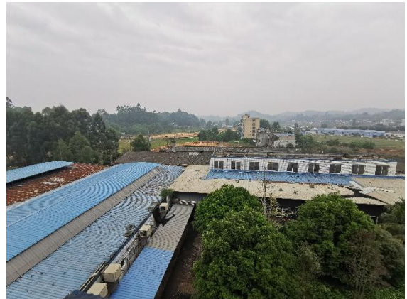
闲置厂房现状
