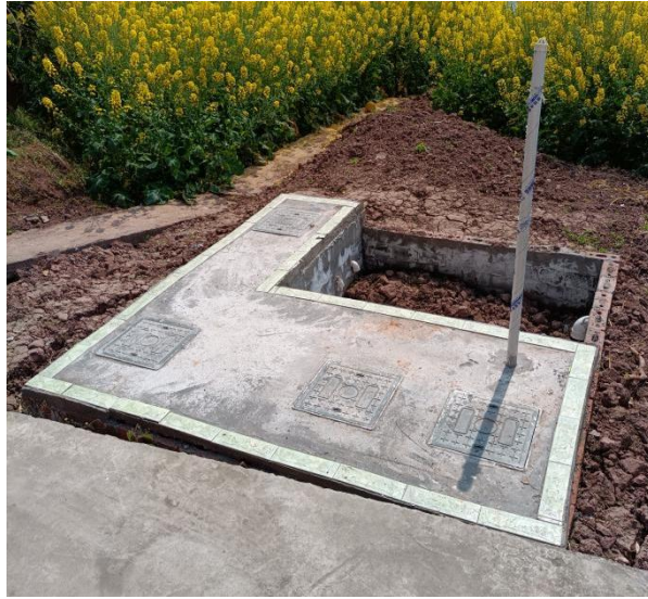
图 2-1 三格化粪池+隔油池+人工湿地模式示意图
