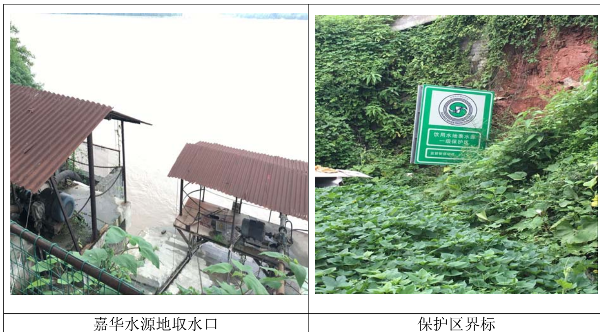
图 2.4-1 嘉华取水口现状
