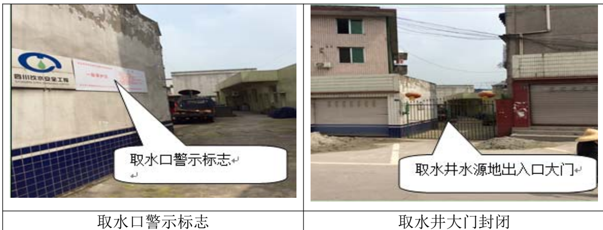
图 2.4-8 新新供水厂取水井现状
