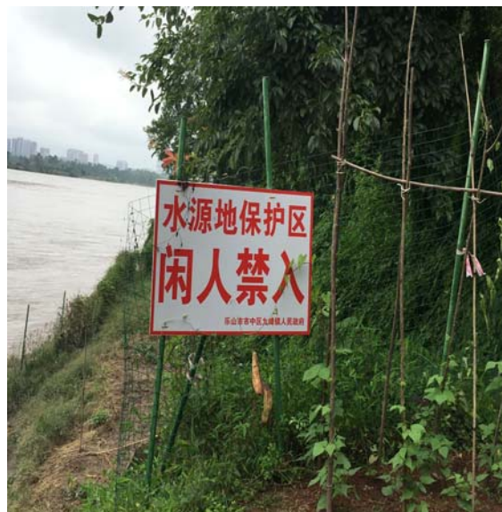
嘉华水源地取水口附近部分防护网缺失
