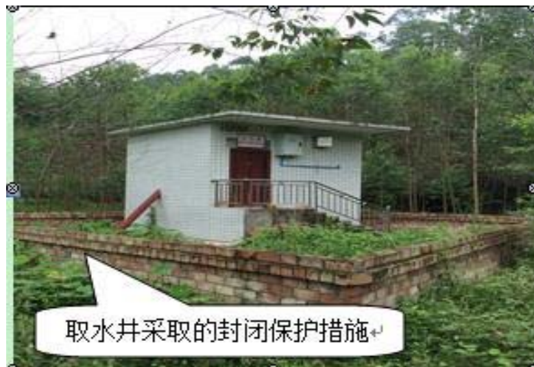
图 2.4-4 白马镇集中供水站取水口现状
