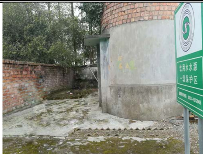
图 2.4-6 临江镇供水站取水井现状
