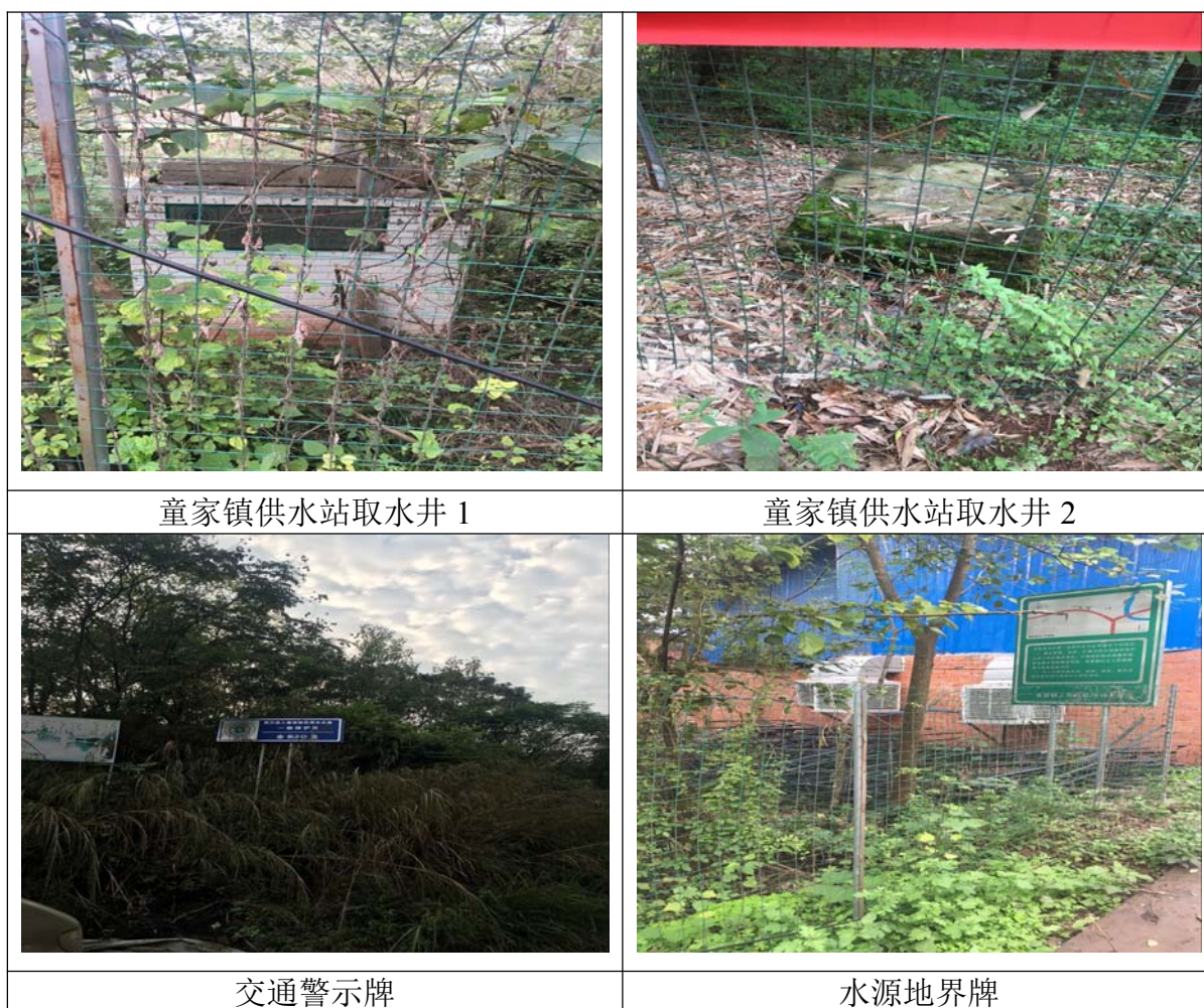
图 2.4-7 童家镇供水站取水井现状
