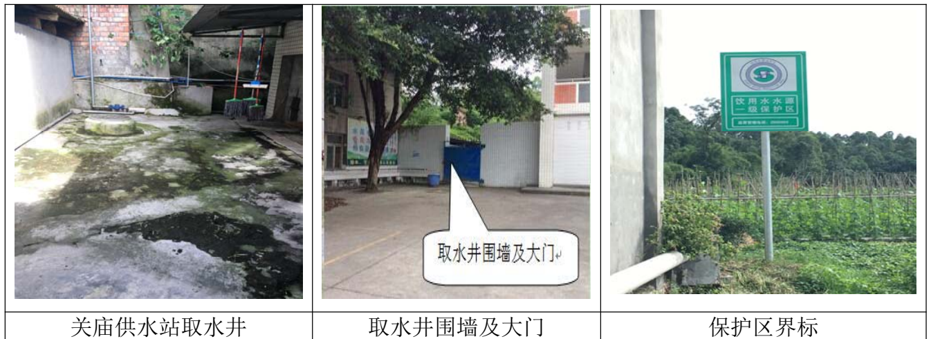
图 2.4-5 关庙乡供水站取水井现状
