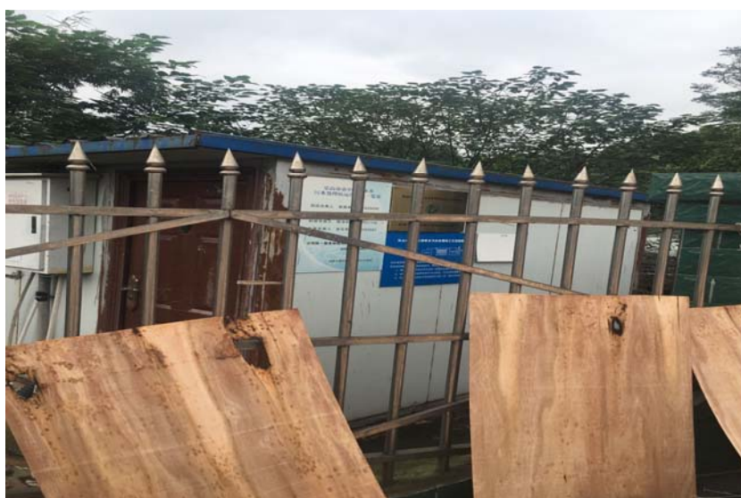
图 4.3-2 石龙乡场镇污水处理厂
