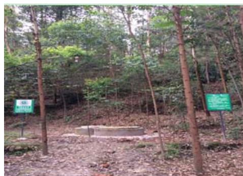
图 2.4-7 剑峰乡供水站取水井现状
