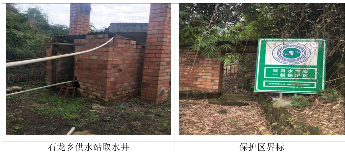
图 2.4-6 石龙乡供水站取水井现状
