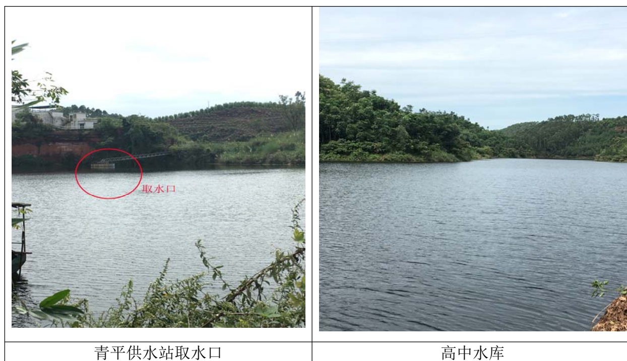
图 2.4-3 青平供水站取水口现状
