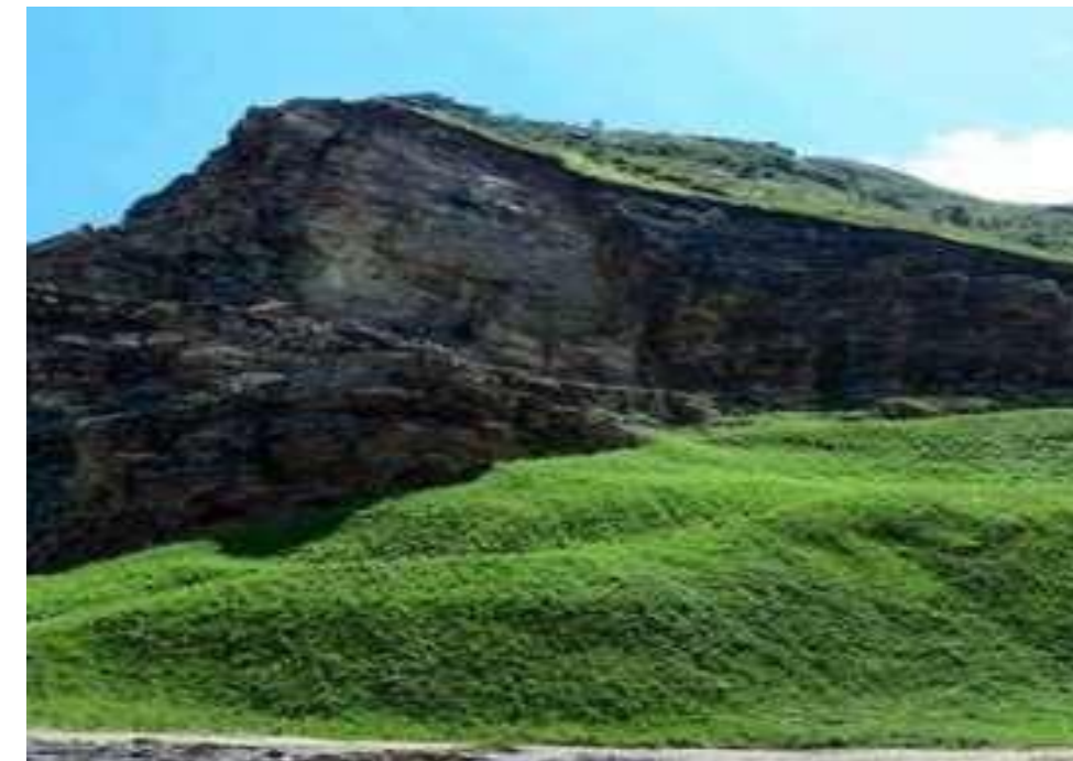
边坡治理修复后
