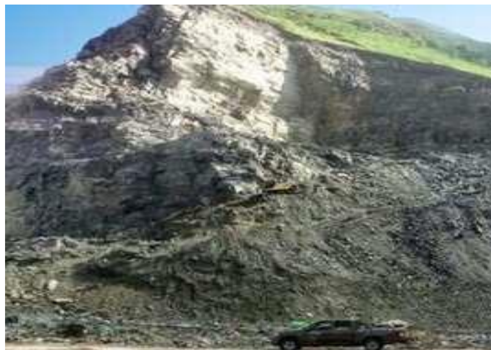
边坡治理修复前
